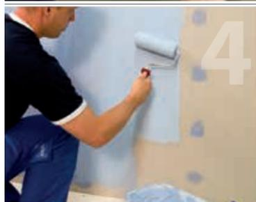
4 Voleliu užtepkite hidroizoliaciją per visą hidroizoliuojamą plotą. Leiskite džiūti apie 2 valandas (džiūnant keičiasi spalva).
