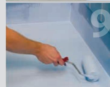
9 Denkite antrą sluoksnį Fibergum ir leiskite džiūti apie 6 val. Įsitinkite, kad hidroizoliacijos sluoksnis yra tolygus. Jei sluoksnis yra nepakankamas, galima tepti papildomai. Hidroizoliacijos sluoksnis ant grindų turi būti 0,5 mm.
