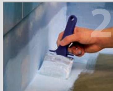
2 Tepkite Fibergum voleliu ar teptuku grindų ir sienų sandūrą, ir įspauskite armavimo juostą. Ją iš viršaus taip pat sutepkite, kad pilnai sudrėktų.
