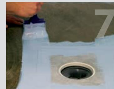
7 Pilnai padenkite trapo sutvirtinimą Fibergum hidroizoliacija.
