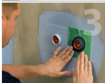
3 Vandentiekio vamzdžiams sutvirtinti naudokite Kiilto movas, kaip alternatyvą galima naudoti Kiilto juostą. Jos viduryje išpjaukite angą, 4 mm siauresnę nei vamzdžio diameteras ir priklijuokite Fibergum pagalba.
