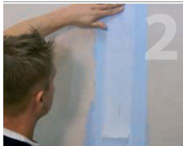
2 Prieš darbą visada išmaišykite hidroizoliaciją. Naudojant teptuką ar volelį užtepkite hidroizoliaciją ant sienų, kampų, vertikalių plokščių sujungimų, varžtų galvučių. Ant šių vietų prispauskite Kiilto sutvirtinimo juostą. Įsitinkite, kad juosta tolygiai sudrėko ir prisiklijavo.
