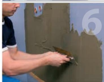
6 Pradėkite klijuoti plyteles nuo grindų antros eilės, ne žemiau kaip 10 cm. Naudokite Jums tinkančius Kiilto plytelių klijus. Plytelių tarpus galima glaistyti praėjus 1 – 3 paroms po plytelių suklijavimo (sekite klijų naudojimo instrukciją).
