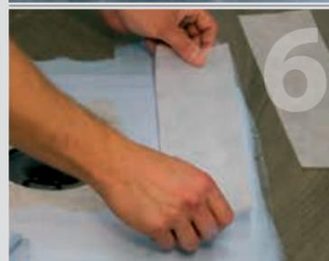
6 Apteptkite trapą iš kraštų ir užklijuokite Kiilto armavimo juostas. Juosta turi uždengti savaime limpančią trapo sutvirtinimą 30 mm.
