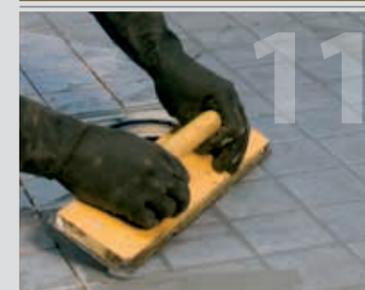
11 Plytelių siūlių glaistymas atliekamas su Kiilto plytelių siūlių glaistais po 1 – 3 parų, kai plytelės buvo užklijuotos (sekite klijų naudojimo instrukciją).
