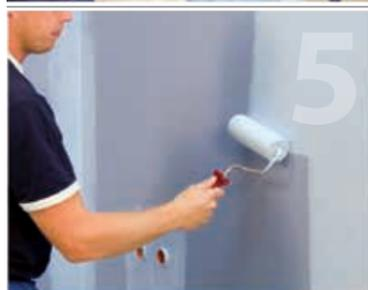
5 Denkite antrą sluoksnį Fibergum ir leiskite džiūti apie 6 val. Įsitinkite, kad hidroizoliacijos sluoksnis yra tolygus. Jei sluoksnis yra nepakankamas, galima tepti papildomai. Hidroizoliacijos sluoksnis ant sienų turi būti 0,4 mm.
